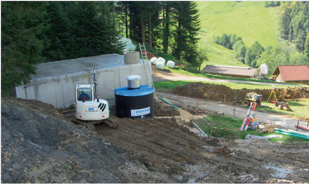
Fig. 2 Exemple d'un kls®filter installé en Suisse
