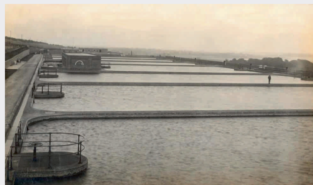
Fig. 1 Filtre lent à Arlington, Angleterre Langsamsandfilter in Arlington, UK
