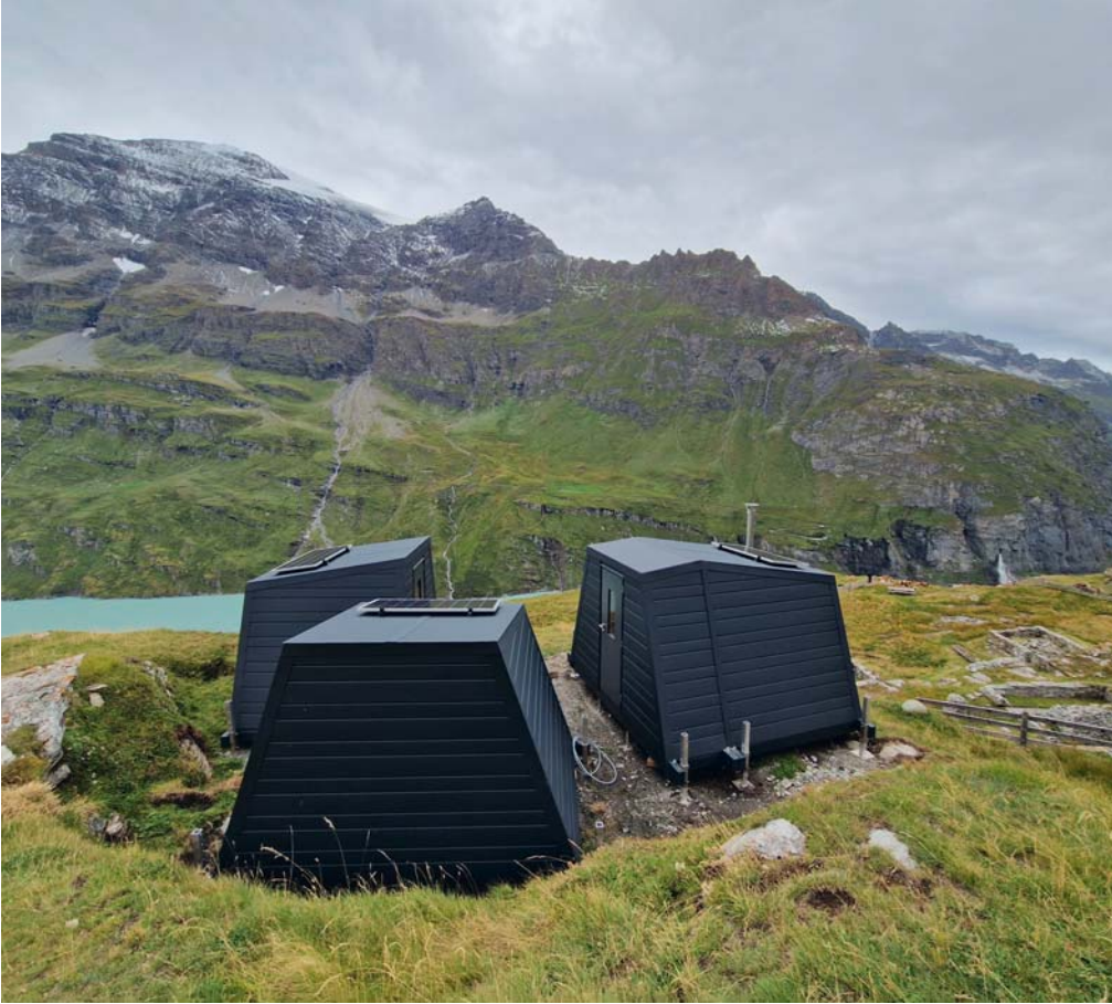
Illustration 3 : Les cabanes de berger de l'alpage de Gietro. L'une d'entre elles est désormais équipée en eau potable grâce au mini-filtre KLS. (Photo: RWB)
